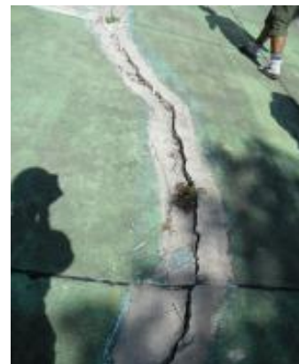
校舎前には地割れの跡が…
