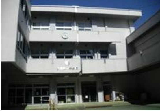
もと第一小学校校舎1階が向学館です。
