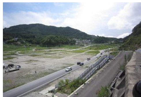
更地となっている女川町中心部
